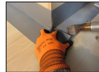
Chauffer les surfaces de la bande à l'air chaude, ensuite compresser; procéder de l'angle vers l'extérieur
