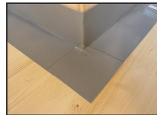
... presser sur le point de contact de l'angle également préchauffé; chevauchement: > 2 cm
