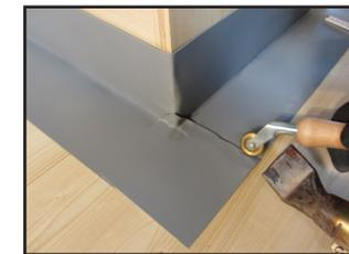
Pour des jontions parfaitement étanches, chauffer les bords et compresser à l'aide d'un rouleau
